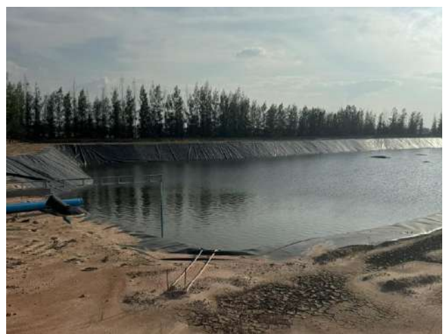
บ่อP7 ปูพื้นบ่อด้วยแผ่น HDPE ขนาดความหนา 1.5 มม.
