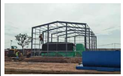
วันที่ 12 มิถุนายน 2568 งานโครงสร้างหลังคาห้องคอนโทรลวัน ทางด้านทิศเหนือ ของปากอุโมงค์ระบาย อากาศ
