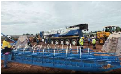
วันที่ 11 มิถุนายน 2568 รถเครนเตรียม ยกโครงสร้างลิฟท์
