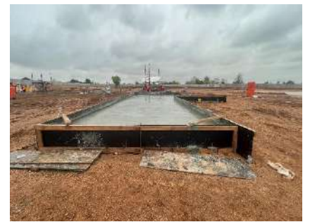
วันที่ 8 มีนาคม 2568 การเทคอนกรีตสำหรับฐานรากเครื่องกว้าน ของเพลาระบายอากาศ
