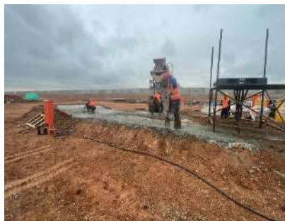
วันที่ 11 มีนาคม 2568 เตรียมพื้นคอนกรีตสำหรับติดตั้งเครื่องอัด ซีเมนต์
