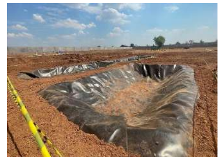
วันที่ 12 มีนาคม 2568 การคลุมพลาสติกบ่อน้ำสะอาด บ่อ สารละลาย และบ่อดักตะกอน สำหรับ เครื่องเจาะ
