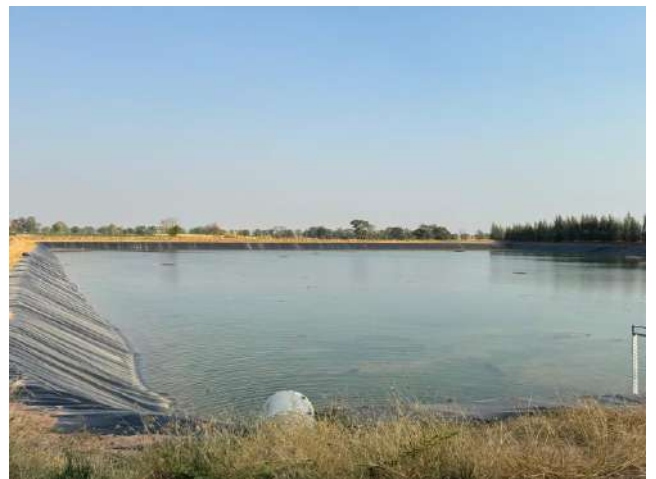
บ่อP10 ปูพื้นบ่อด้วยแผ่น HDPE ขนาดความหนา 1.5 มม.
