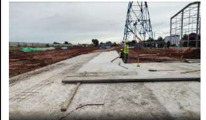
วันที่ 13 มิถุนายน 2568 งานสร้างพื้นคอนกรีตทางเชื่อมหลักเข้า ไปหาด้านหลังโครงสร้างลิฟท์ของปาก อุโมงค์ระบายอากาศ
