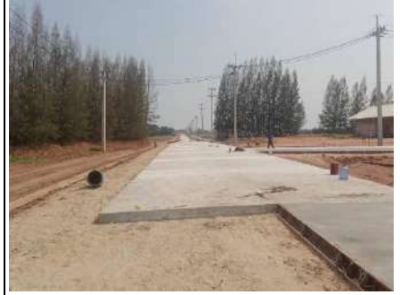
วันที่ 4 เมษายน 2568 การสร้างถนนคอนกรีต เชื่อมต่อกับสาย หลักไปบริเวณก่อสร้างอุโมงค์ใหม่
