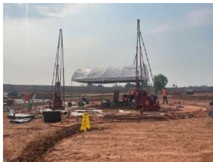
วันที่ 14 มีนาคม 2568 ทดสอบปริมาณน้ำที่ไหลเข้าบ่อ ในส่วนของ งานชุดเจาะ
