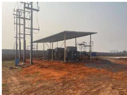
วันที่ 24 มีนาคม 2568 การติดตั้งหม้อแปลงไฟฟ้า เพื่อใช้ในงานก่อสร้างบริเวณอุโมงค์ใหม่
