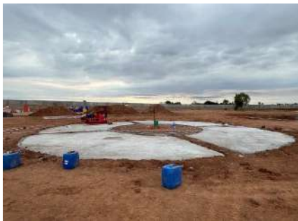
วันที่ 7 มีนาคม 2568 เตรียมฐานรากสำหรับแท่นขุดเจาะที่ปล่อย ระบายอากาศ
