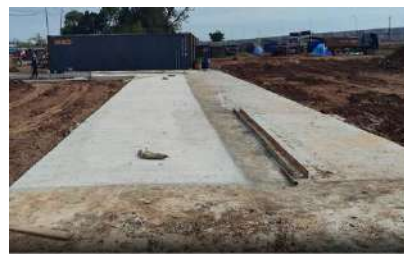
วันที่ 12 มิถุนายน 2568 งานสร้างถนนคอนกรีตภายในไซต์งาน
