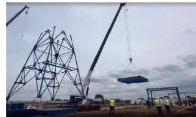
วันที่ 12 มิถุนายน 2568 งานยกโครงสร้าง HEAD FRAME ที่ปาก อุโมงค์ระบายอากาศ
