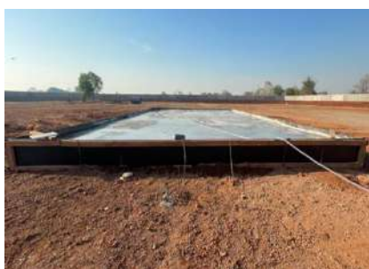
วันที่ 1 มีนาคม 2568 เทคอนกรีต สำหรับงานก่อสร้างฐานราก แท่นขุดเจาะเครื่องจักรชั่วคราว
