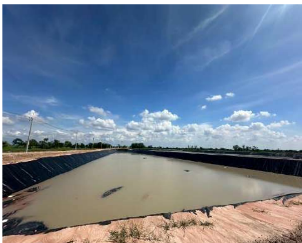
บ่อP9 ปูพื้นบ่อด้วยแผ่น HDPE ขนาดความหนา 1.5 มม.
