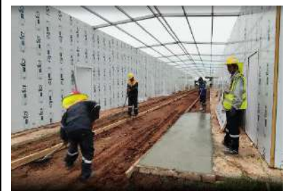
วันที่ 13 มิถุนายน 2568 งานเทคอนกรีต เพื่อก่อสร้างออฟฟิศ ชั่วคราวของผู้รับเหมา
