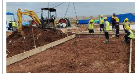
วันที่ 11 มิถุนายน 2568 งานเข้าแบบเพื่อเทคอนกรีตทางด้านทิศ เหนือของปากอุโมงค์ระบายอากาศ
