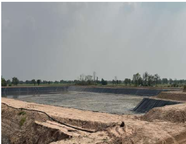
บ่อP8 ปูพื้นบ่อด้วยแผ่น HDPE ขนาดความหนา 1.5 มม.
