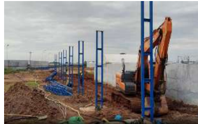
วันที่ 11 มิถุนายน 2568 งานติดตั้งรางวางสายไฟ ทางด้านทิศใต้ของ กำแพง
