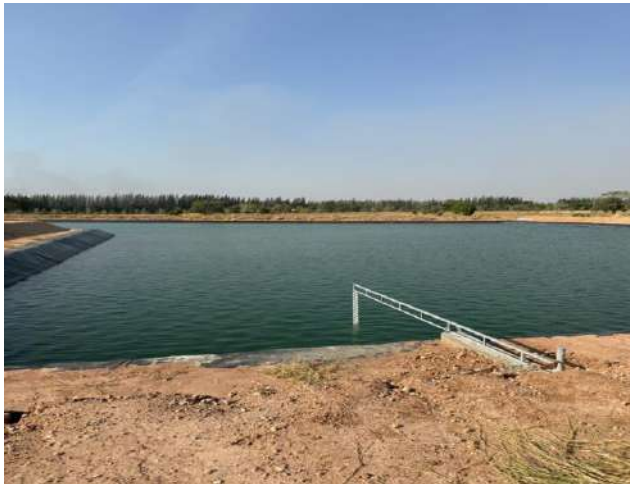
บ่อP3 ปูพื้นบ่อด้วยแผ่น HDPE ขนาดความหนา 1.5 มม.
